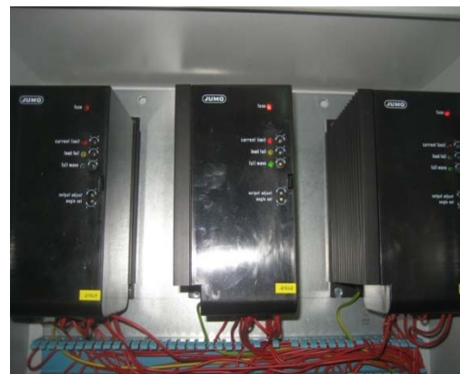
Slika 7. Slika tiristorskih sklopki za regulacija temperatura grijača
