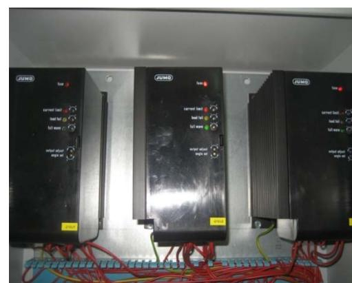
*Slika 7. Slika tiristorskih sklopki za regulaciju temperaturna grijaca*
